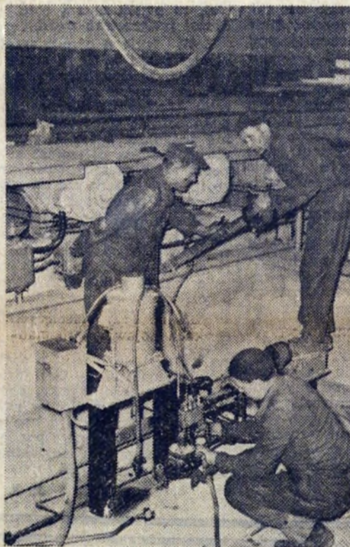
W trakcie wstępnej eksploatacji usuwa się zauważone drobne usterki. Każde urządzenie musi dobrze funkcjonować.
