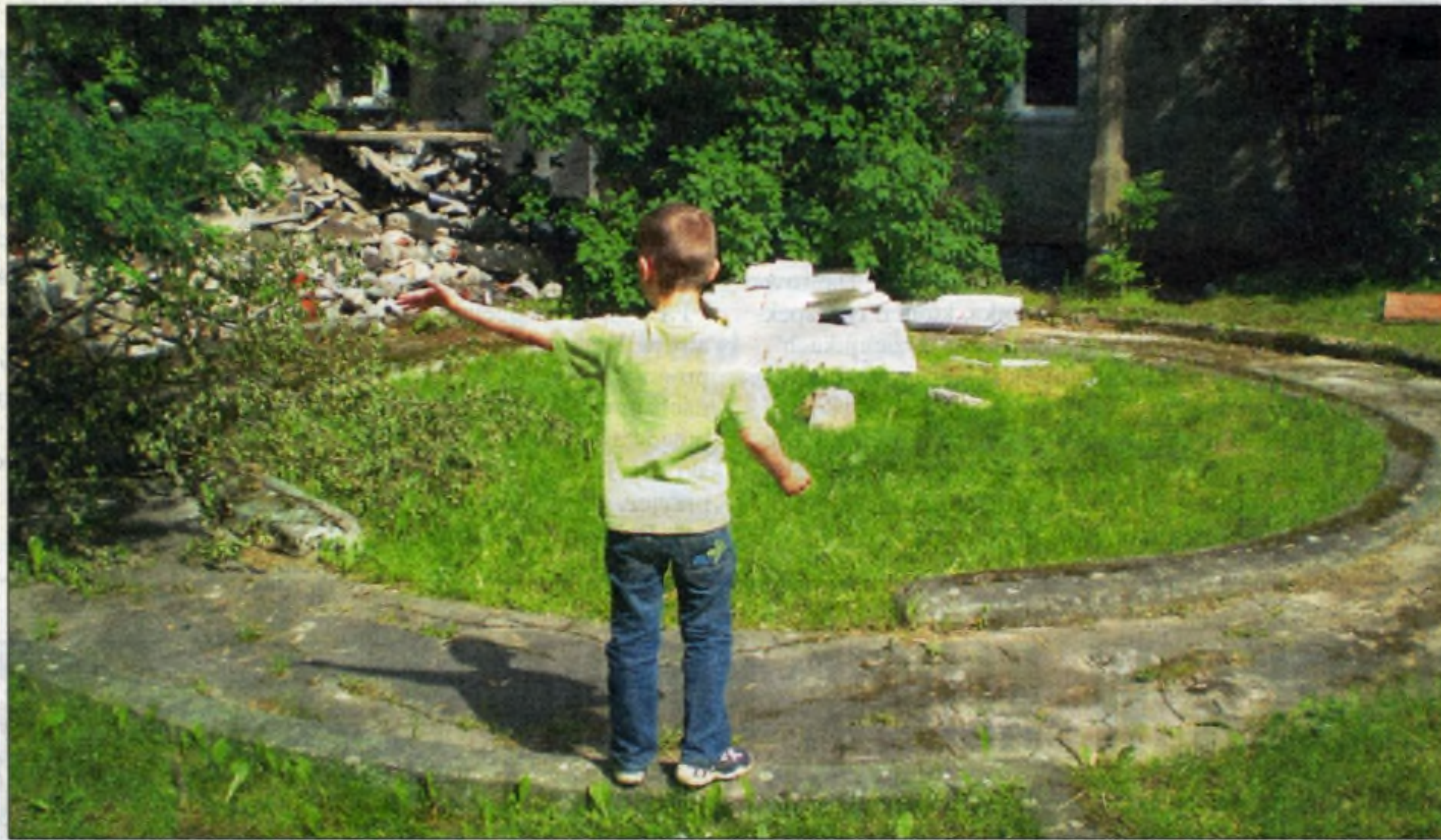
Betonowe elementy brodzika zostaną zlikwidowane.
