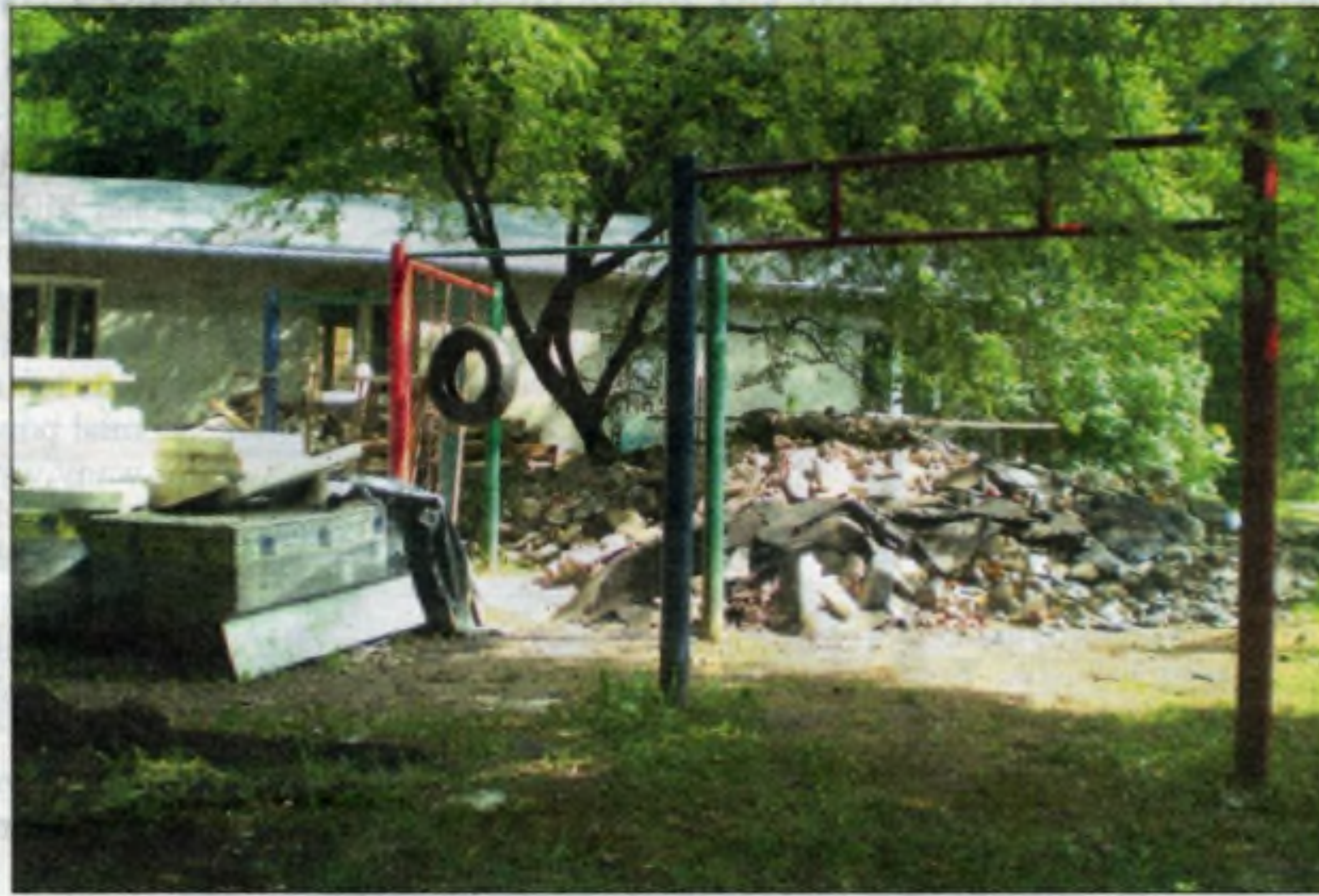
Trwają prace przy rewitalizacji terenu ogródka.
