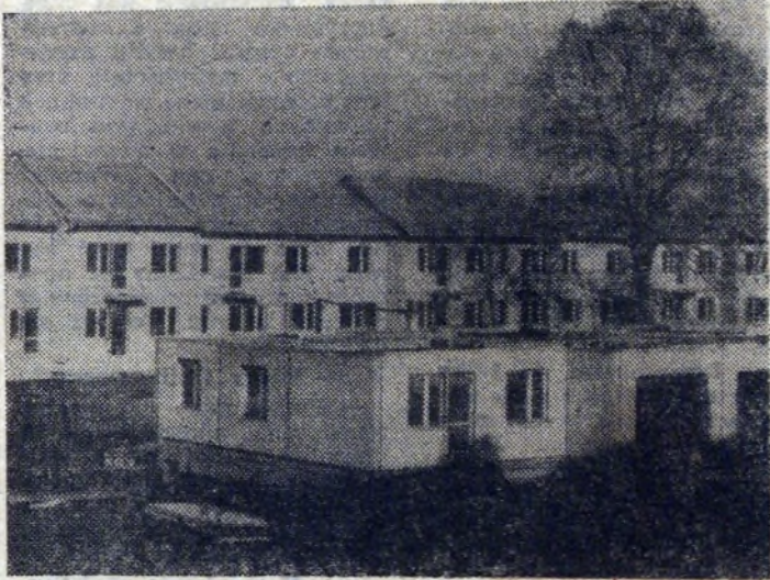
Te domy wyrosły jak grzyby po deszczu, MISTRZEJOWICE -CENTRUM, domki jednorodzinne budowane przez SZBDJ „Zgoda”.
