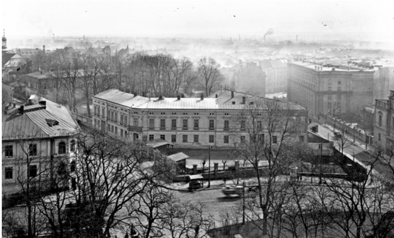
Rozległy, choć jednopiętrowy gmach mieszczący biura akcyzy stał w latach 1898–1958 pomiędzy ulicami Kopernika i Zyblikiewicza. Po likwidacji sieci akcyzy (1936), pełnił funkcje mieszkalne. Fot., NAC, 1928
