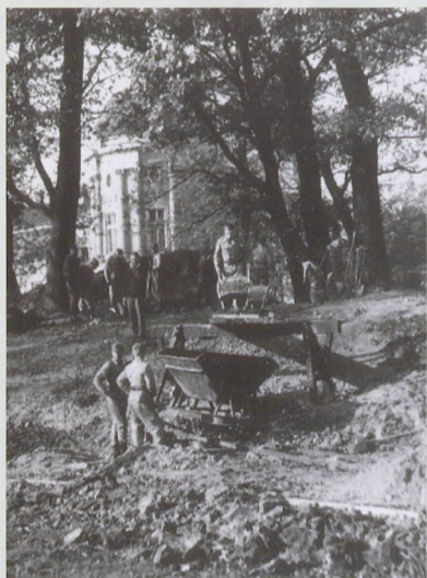
Ryc. 22. Budowa stadionu sportowego w 1966 r., fot. arch. ze zbiorów TPP
