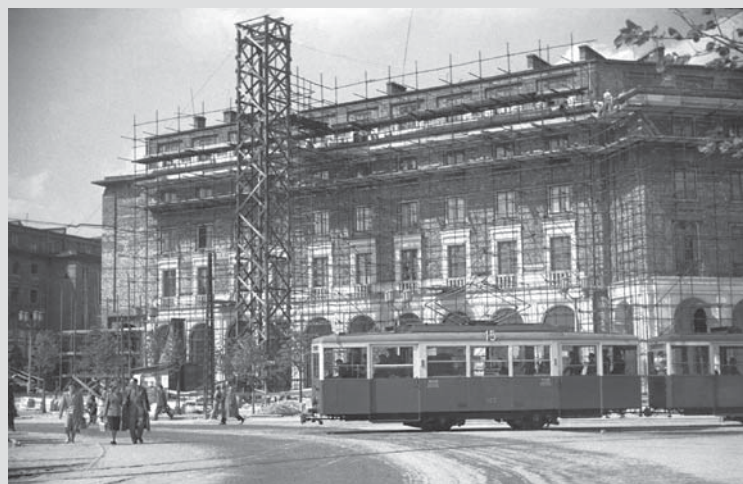
Początki budowy Nowej Huty – zdjęcia Henryka Makarewicza, autora dokumentacji fotograficznej powstania tej dzielnicy, którego wystawa jest prezentowana w Bibliotece Kraków, Filia nr 54, os. Młodości 8
