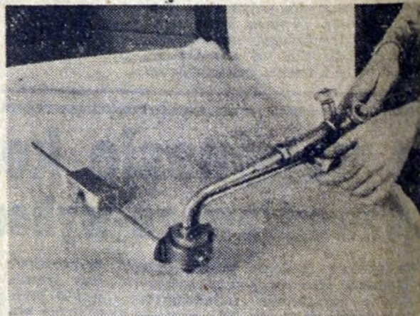
Zdjęcie przedstawia czynność cięcia blachy przy pomocy zmodernizowanego cyrka obrtowego.
