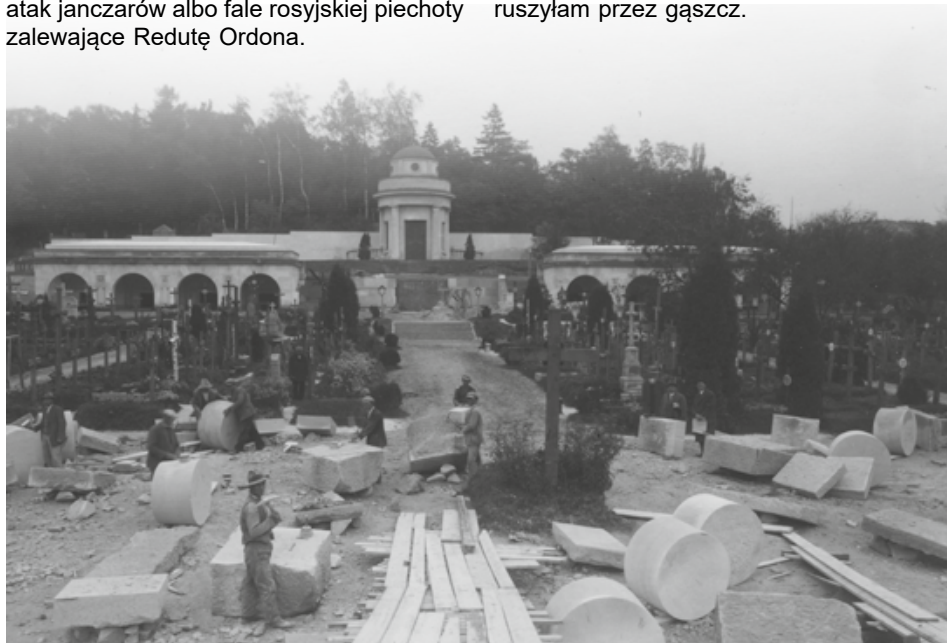
Lwów. Budowa. Cmentarza Obrońców Lwowa
