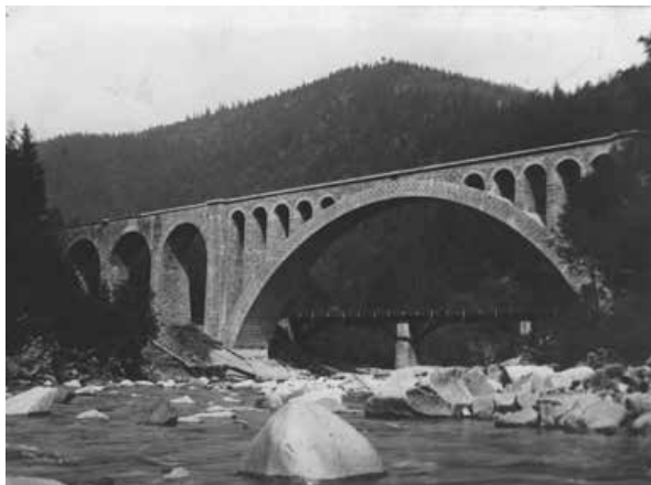
Most kolejowy nad Prutem w Jaremczu
