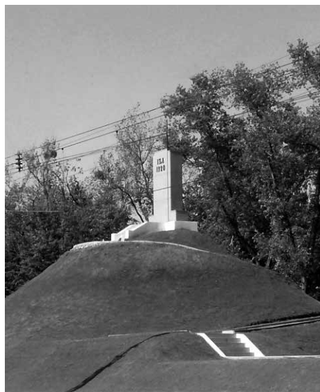
Kurhan w Zadwórz, stan z czerwca 2019 r., po remoncie wykonanym w 2015 r., fot. Grzegorz Hetnar
