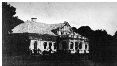
Bębnowka Wielka. Widok palacu Narkiewiczów Jodko od strony frontowej. Fotografia sprzed roku 1914 [wg Urbański 1929]
