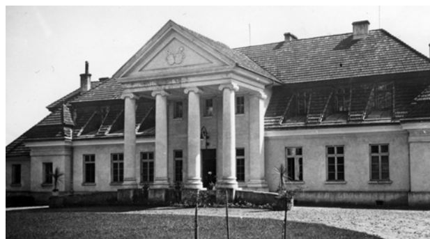
Pałac w Bolszowcach odbudowany przez Kornela Krzeczunowicza
