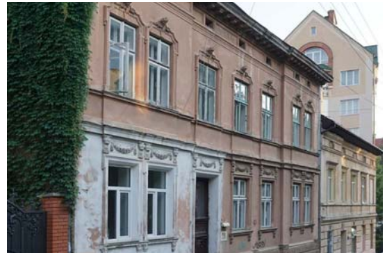
Kamienice nr 29 i 31 przy ulicy Mochnackiego, Wikipedia – domena publiczna
