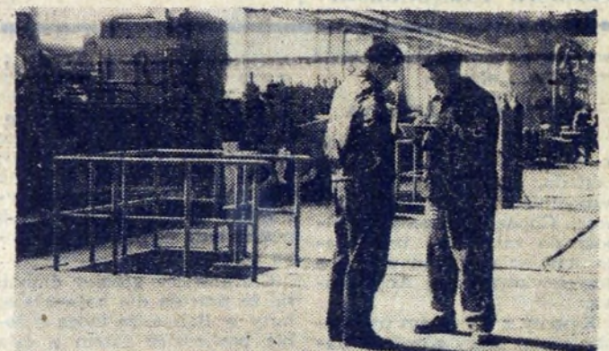
W potężnej hali Wydziału Rur Zgrzewanych myśli i mówi się już tylko o rozruchu.
