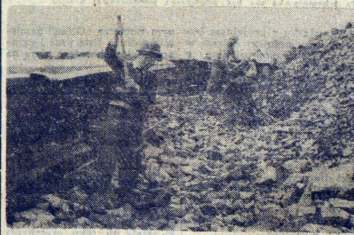
Tak wygląda jeszcze praca na najwyższym poziomie. Wkrótce spracowane ręce i kilof zastąpi koparka.
