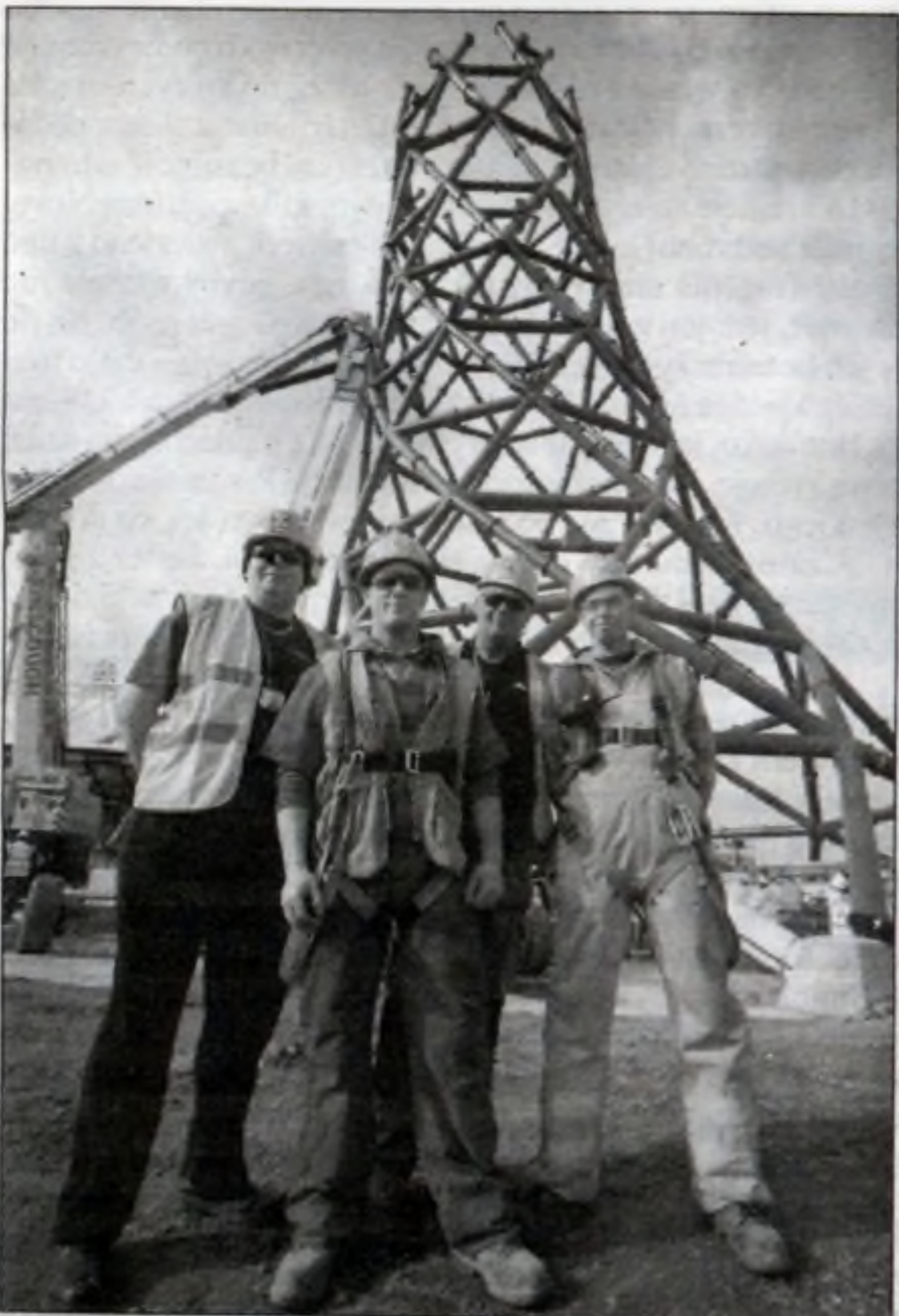
Budowa w trakcie.
