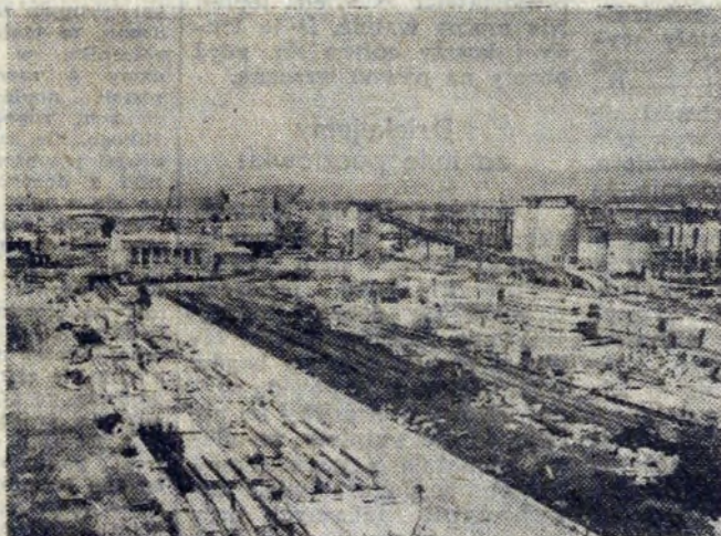
Na zdjęciu — fragment budowy kombinatu hutniczego w Kremikowcach.
