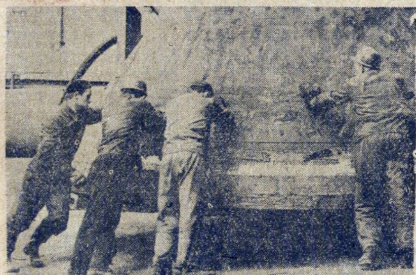
Podniesienie tzw. „dzwonu” na górę pieca. W tej chwili jest już po operacji.
