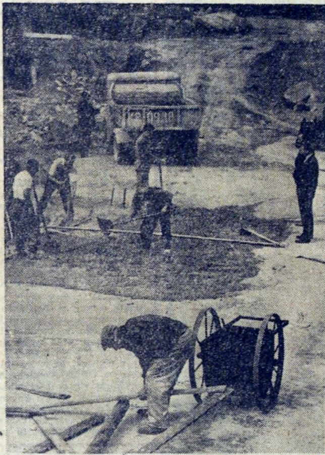
Na budowie wielkiego pieca nr 4. Fot. J. BROŻEK
