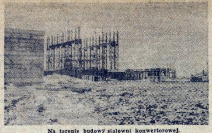
Na terenie budowy stalowni konwertorowej.
