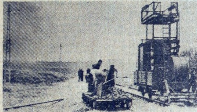
Za chwilę nad gotowymi torami rozpięte zostaną przewody.
