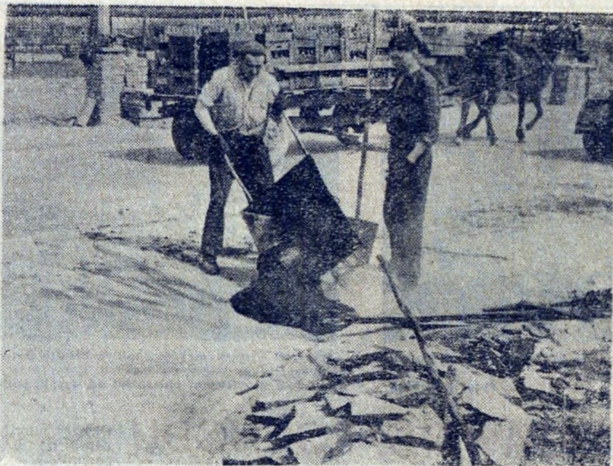
Naprawa zniszczonej nawierzchni dróg i chodników w kombinacie.
