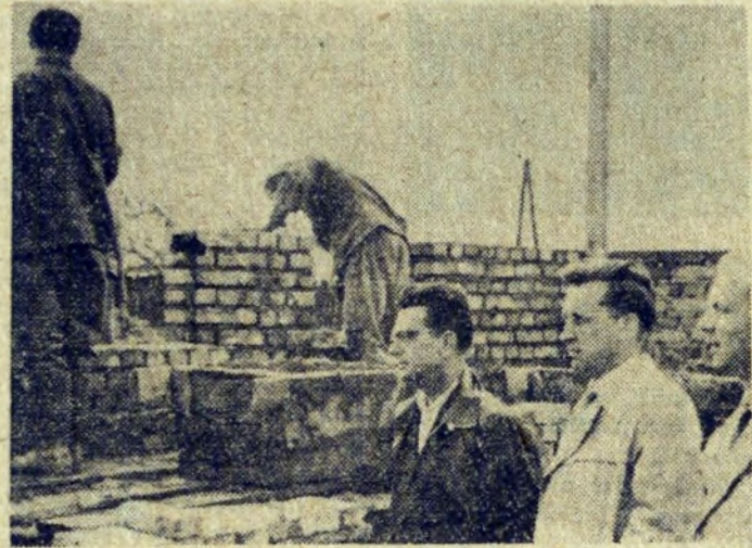
Członkowie kierownictwa spółdzielni z prezesem tow. Cz. Sarną na czele wizytują rozpoczętą budowę. Fot. S. GAWLIŃSKI
