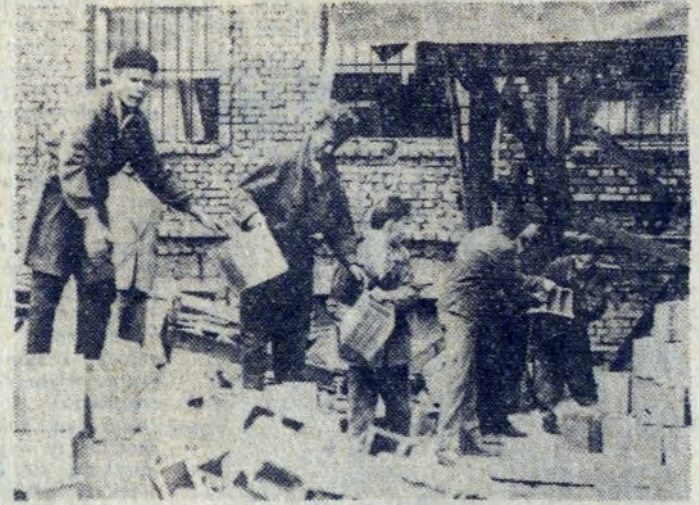
Cegła do cegły i szkoła „idzie w górę”.
