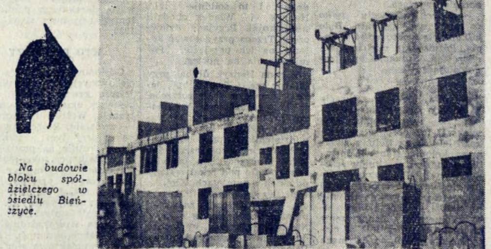
Na budowie bloku spółdzielczego w osiedlu Bięczyce.
