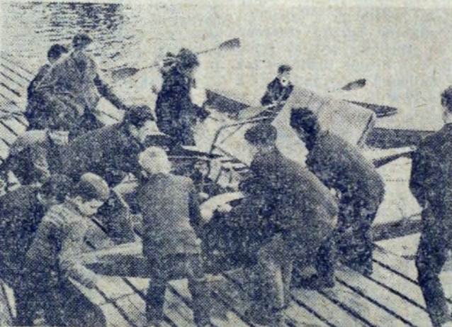
Młodzież z Zasadniczej Szkoły Budowlanej PPB III L przy realizacji swego zobowiązania na terenie Zalewu.
