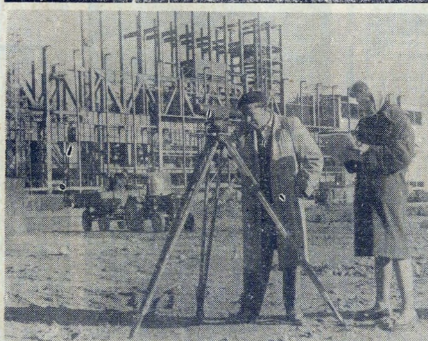
Równoległe z budową Stalowni Konwertorowo-Tlenowej trwają pomiary geodezyjne. Front robót staje się coraz szerszy.
