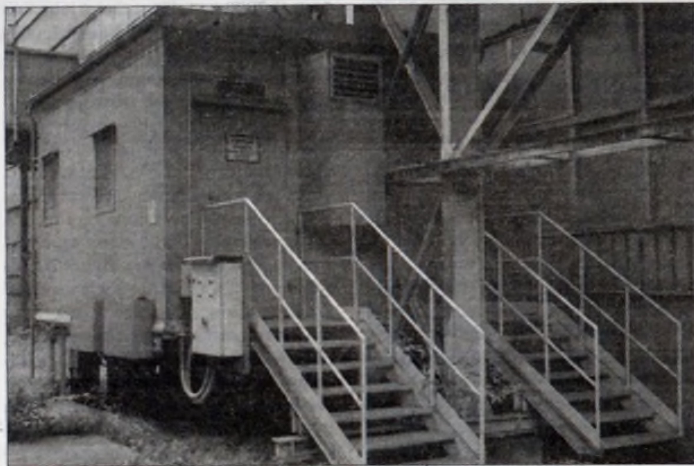
Takie zabudowy wyciszają m.in. urządzenia w linii produkcji spieku krakowskiej spiekalni.
