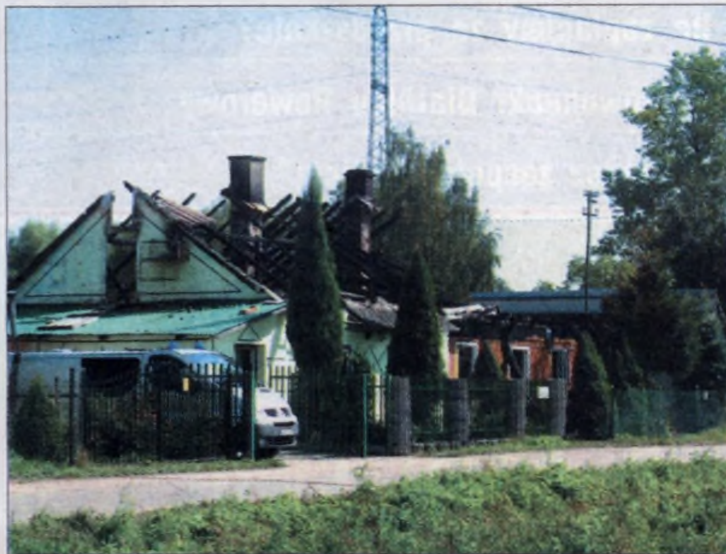
Domy, przy których rozbiła się cessna, nadają się tylko do rozbiórki.
