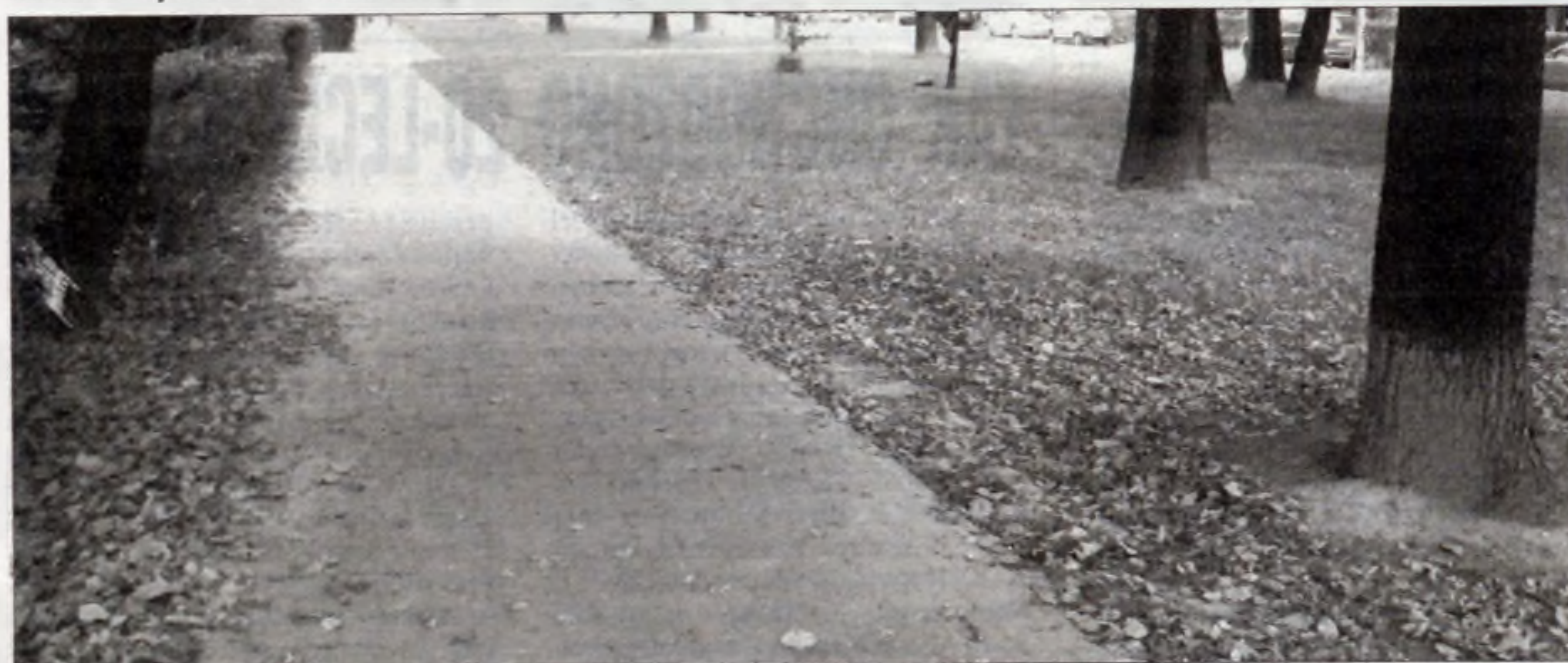
Chodnik po remoncie na os. Willowym.
