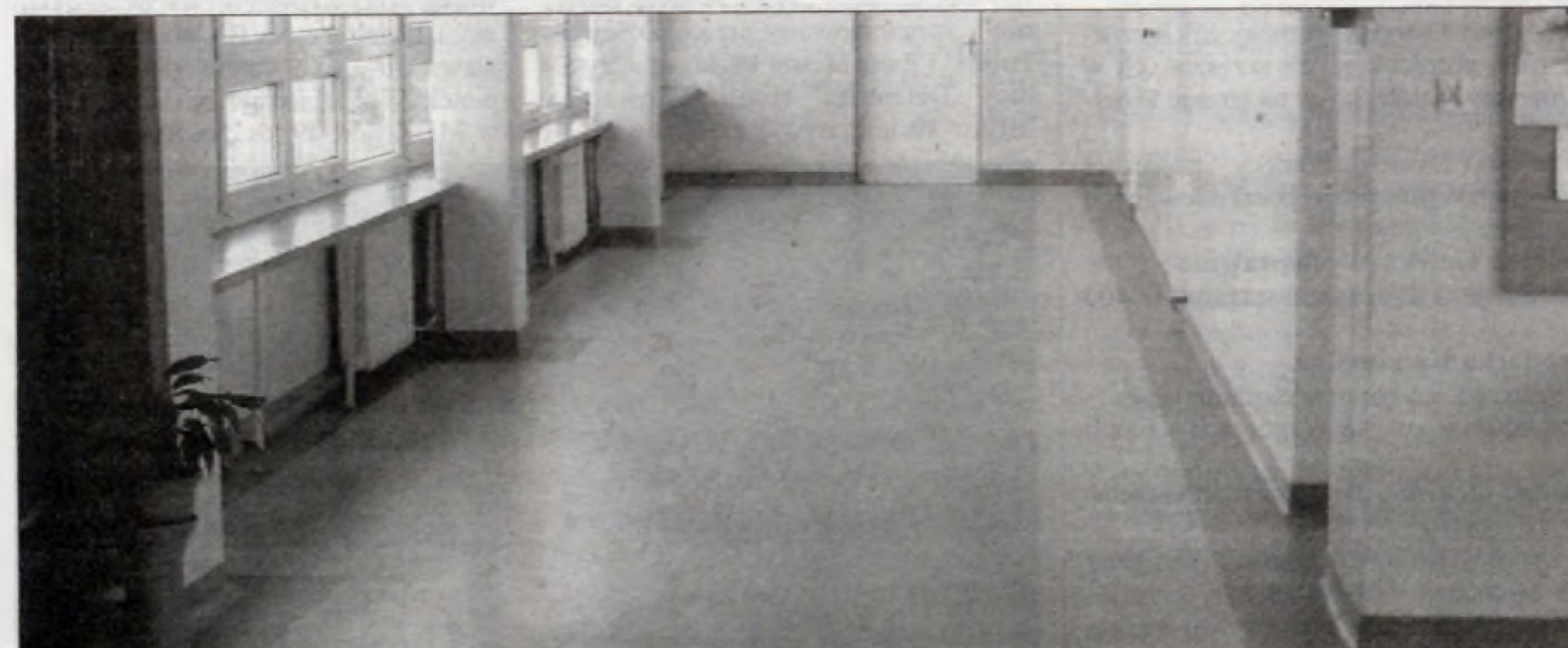
Nowa wykładzina na korytarzu szkolnym.
