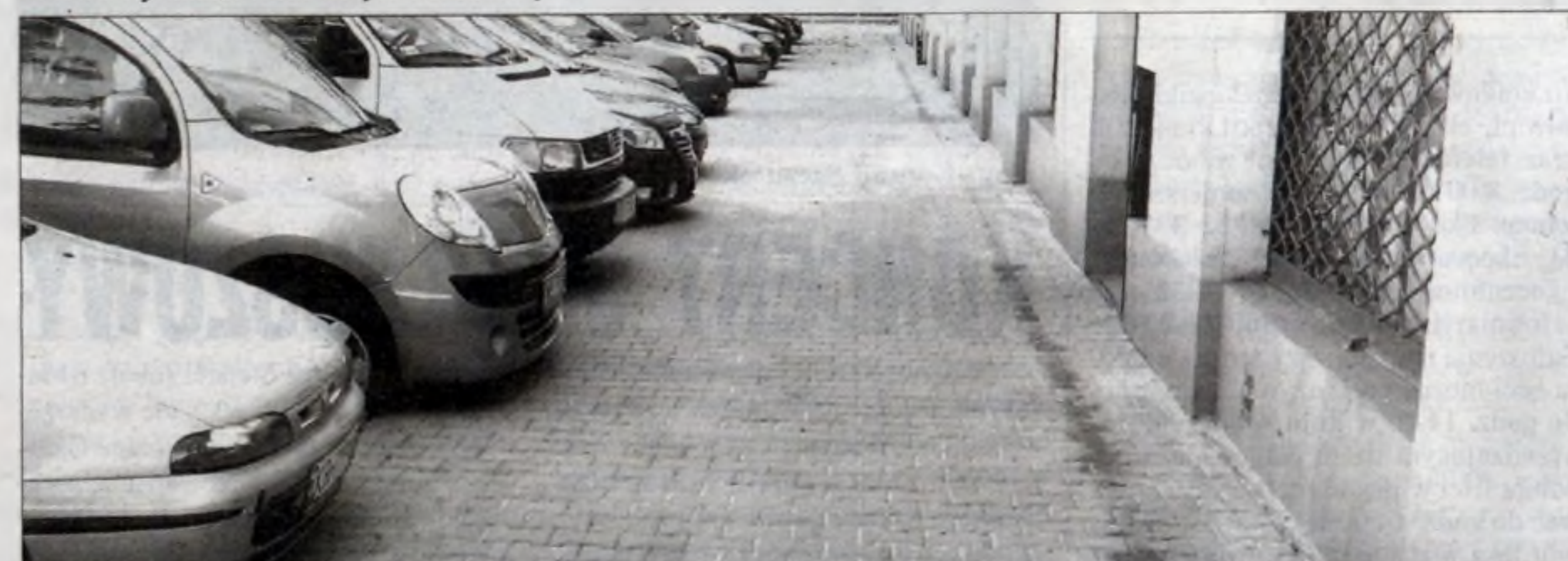
Nowy chodnik na ul. Danilowskiego.
