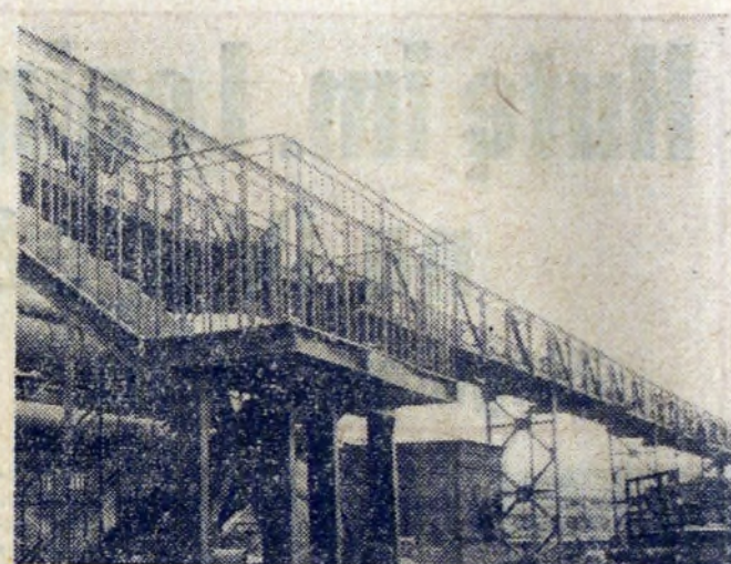
Oto widok na most dla pieszych wybudowany nad torami w rejonie Wielkich Pieców. Niestety schody stanowią zbyt karkołomne wejście, nie mówiąc już o tym, że zejść po nich jest jeszcze trudniej. Czy nie zauważyła tego komisja odbioru?
