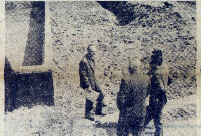
Na budowie basenu kąpielowego w Nowej Hucie. Pierwszy od prawej: kierownik budowy mgr inż. Karol Markowski.
