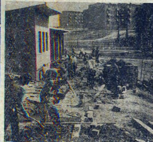
Zakładanie chodnika przy głównym wejściu do Ogrodu Jordanowskiego w Krzesławicach wykonanego w czynie społecznym. Prace te wykonuje brygada z Wydziału W-97. Na dalszym planie — pracownicy Wydz. W-41.
