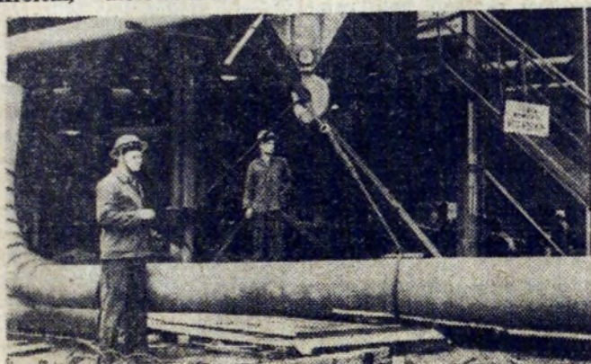
Oto monterzy HPR przy pracy. Ten rurociąg jest już zaczepiony na linie, za chwilę dźwиг uniesie go w góre, na stanowisko montażowe.
