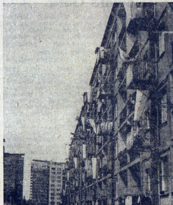
Mieszkańcy postarali się o odświeżony wygląd tego budynku. Na balkonach zawisły białe-czerwone flagi.
