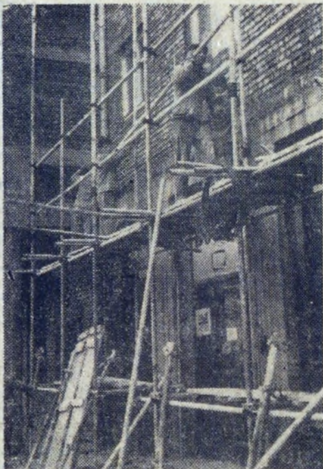
Tynkowanie, tynkowanie. Czekają na tę kosmetykę nowohuckie bloki. Jeszcze nie wszystkie są jasne i kolorowe, a przecież każdy z nas chciałby mieszkać w budynku ładnie otynkowanym. Bo to i przyjemniej w lecie, i nieco cieplej w... zimie. A więc do dzieła, obywatele tynkarze.
