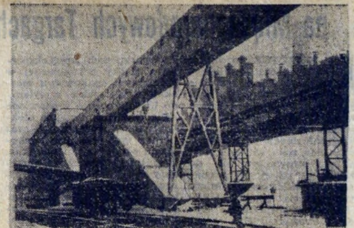
Nowość techniki: nośnice powłokowe w Aglomerowni, smontowane przez mostostalców.
