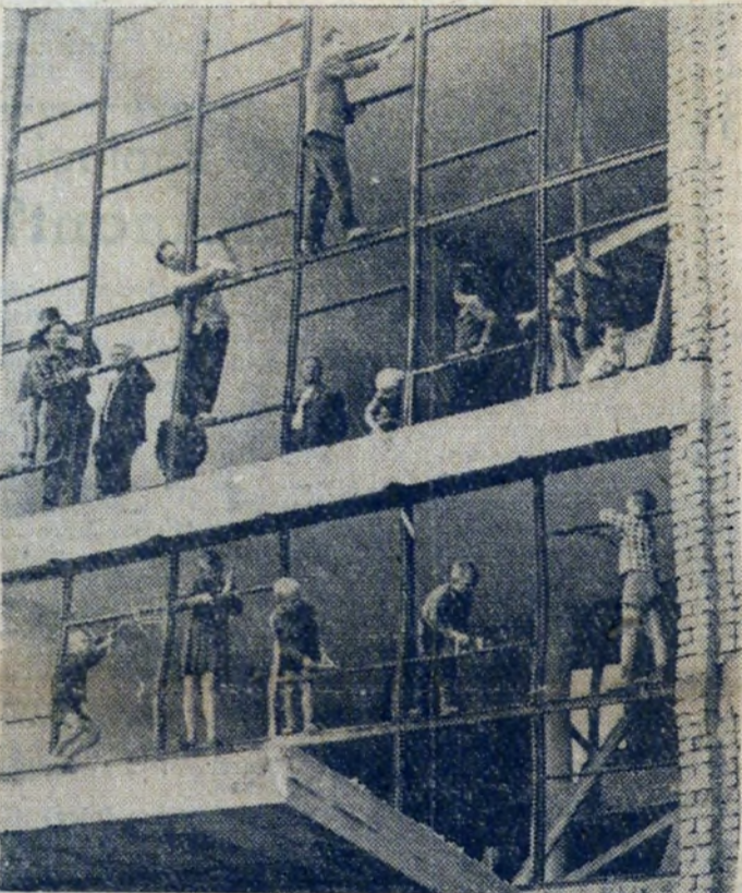
W szkole na Os. Kolorowym przyszli uczeńowie oraz ich rodzice pomagają budowlanym w robocie. Tutaj odbywa się czyszczenie metalowych ram okiennych. Pomoc - bardzo cenna.
