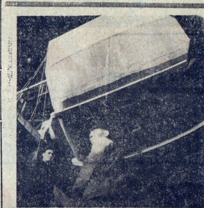
Oto przy montażu urządzeń w Stalowni Konwertorowej.
