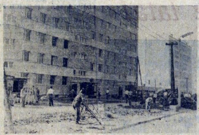
W osiedlu Bieńczyce E trwają prace wykończeniowe przed dwoma największymi w Nowej Hucie wieżowcami, które mają być oddane do użytku jeszcze w tym miesiącu. Fot.: J. PODLECKI
