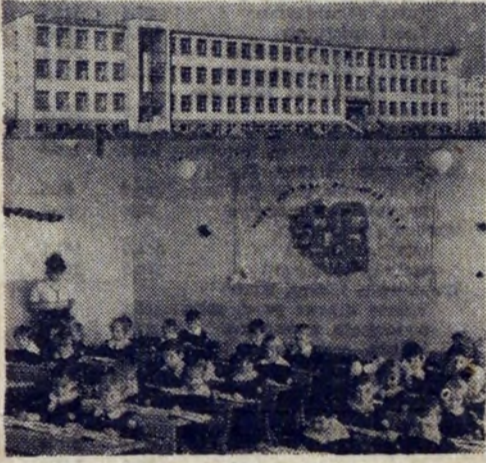
Niecodzienna uroczystość przeżyli dzieci zamieszkałe na osiedlach: Wysokim, Na Lotniskach, Strusia i Kalinowym — w dniu 1. X. nastąpiło otwarcie nowej szkoły podstawowej. Piękny i nowoczesny budynek mieści w swych murach około 900 dzieci. Obok pięknych boisk, nowoczesnych sal lekcyjnych, pracowni i gabinetów lekarskich — na miejscu znajduje się stołówka.
