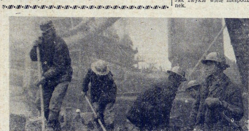
Betoniarze z brygady Józefa BIEŃKA (ZBM-1) przy robotach w rejonie w. pieca nr 5.
