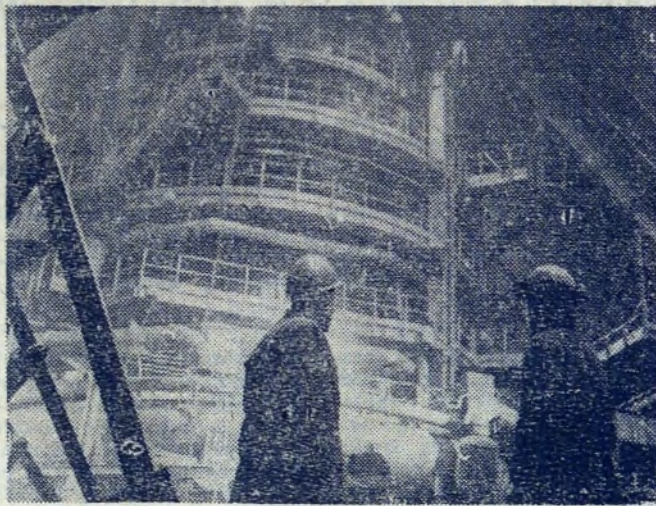
Ostatnie prace wykończeniowe w hali leźniczkiej wp. nr 5. Stalowy kolos jeszcze drzemie w bezruchu, wkrótce — ruszy. Foto: ST. GAWLIŃSKI
