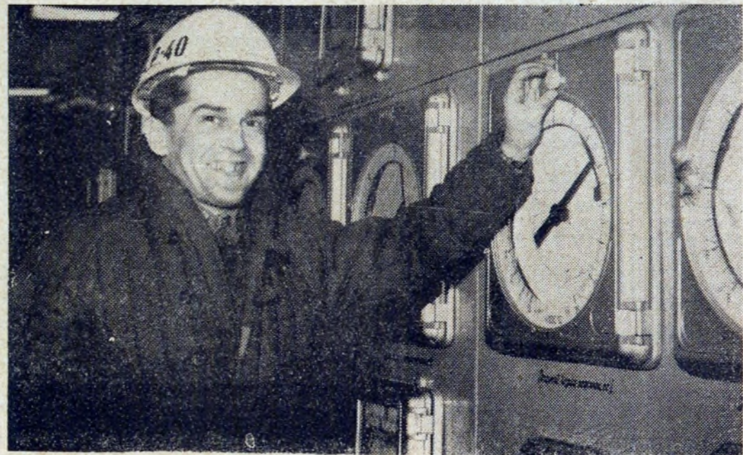
I nagrzewnicowy piątego wielkiego pieca — E. Czyż przy pracy.
