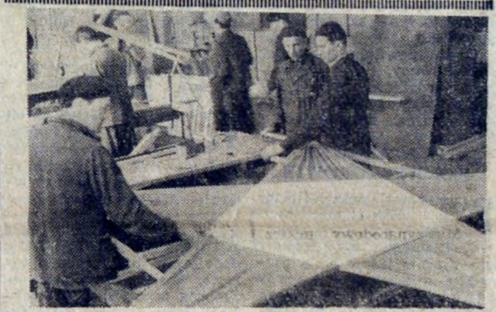
Tak powstawały w Wydziale Remontów Budowlanych elementy dekoracyjne do 1-Majowego pochodu. Fot.: ST. GAWLIŃSKI
