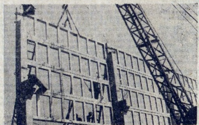
Obok starego, zmuszającego już zakładu prefabrykacji powstaje nowa, piękna hala produkcyjna. Obiekt ten — jak wszystkie obiekty budowlane — posiada lokalizację tymczasową. Istnieje jednak możliwość rozebrania hali po paru latach i ponownego wykorzystania jej elementów. Inwestycja ta zamortyzuje się jeszcze w ciągu roku, półtora.
