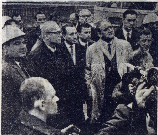
Wicepremier, przewodniczący Komitetu Nauki i Techniki Eugeniusz Szyr z wicedyrektorem ministra Mariana Olewińskiego, dyrektora PPB HiL Ryszarda Geyera i kierownika budowy Edwarda Barszcza Walcowni Slabing.
