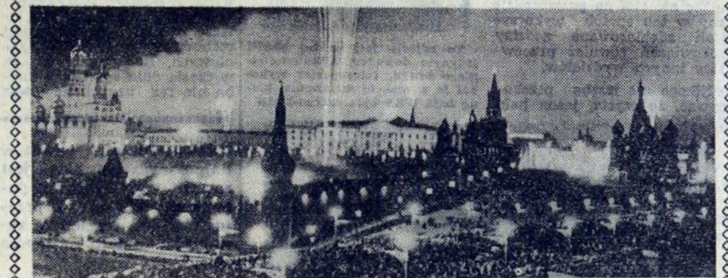
Moskwa w świetło (zdjęcie na dole). Dwupoziomowy most (u góry)
