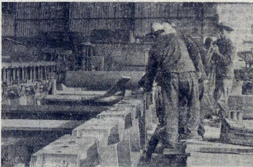
Nieprzerwanie trwa montaż urządzeń ra-dzieckich. O oostępie robót na budowie Slabingu piszemy na str. 3. Fot. B. LUCKOS
