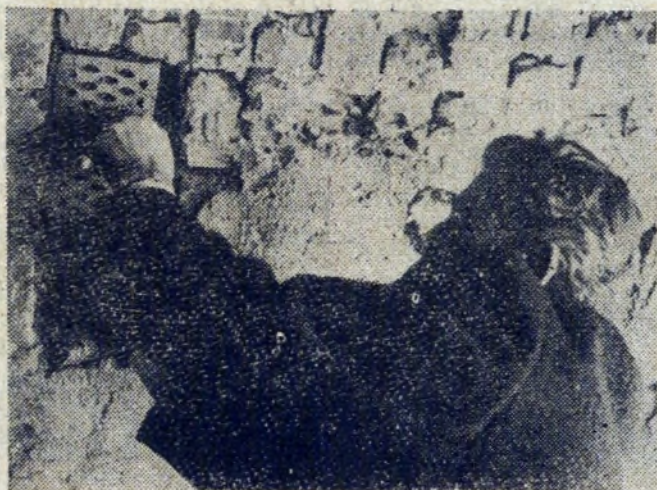
Kilka ruchów kielnią i metalowa puszka już zamurowana. Fot. ST. GAWLIŃSKI
