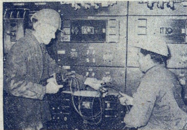
Przy montażu tablicy rozdzielczej na hali Slabingu brygadzi- sta z Elektromontażu T. Wojciechowski i M. Książek.
