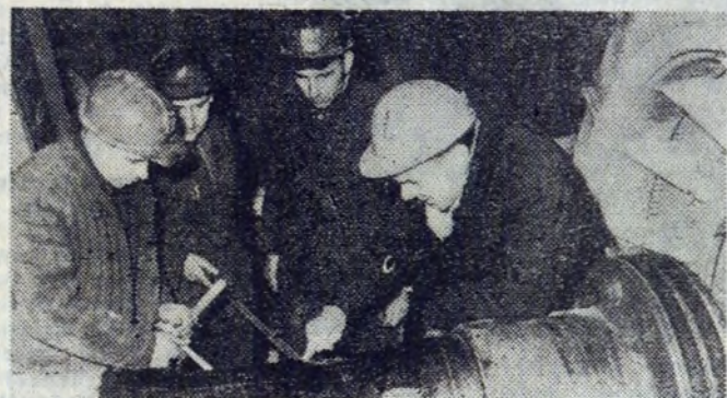
Mostostalowcy montują urządzenia w jednej z maszynowni. Na zdjęciu kierownik inż. Starzak oraz członkowie brygady J. Berka, W. Skuratowicz i K. Pieniążek.
