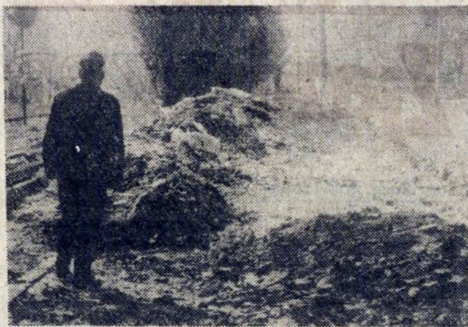
Ten odcinek drogi nr 1 wraz z chodnikami nie jest do przebycia a to „zawdzięczać” można kierownictwu i kierownikowi Zakładu Płynnych Betonów.
