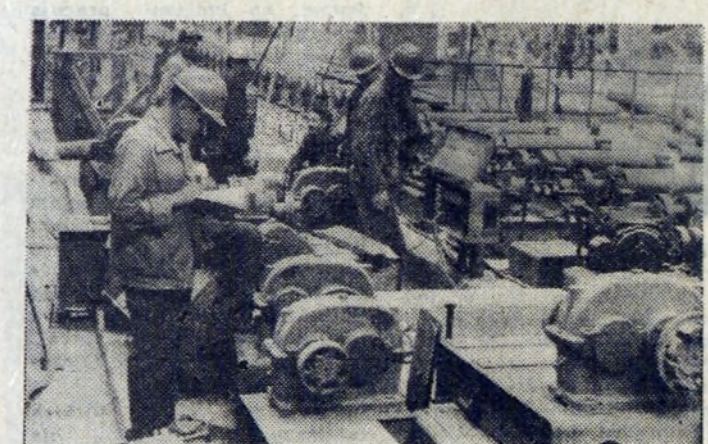
Pracownicy „Elektromontażu” przy montowaniu urządzeń sterowniczych samotoku dla walcowni taśm. Fot. St. Gawliński
